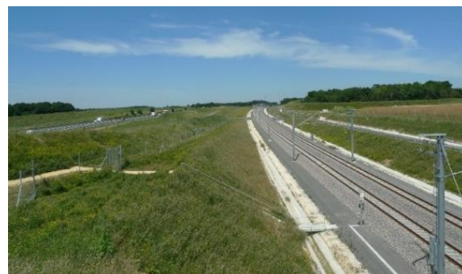
Figur 3-9: Slänter i jordskärning som har etablerats med vegetation. (foto Erik Kajo, Trafikverket)
