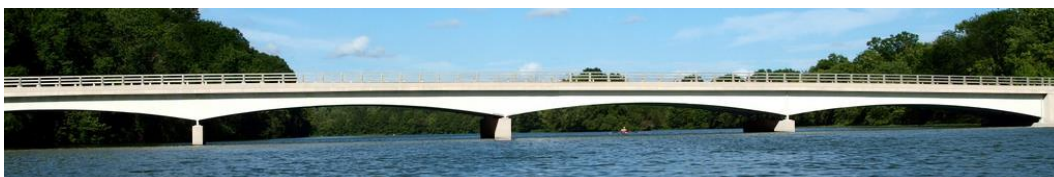
Figur 4-10 Exempel på broutformning med ett sammanhållet utseende. Brostöd, brobalk, kantbalk och räcke samspelar då alla delar har samma färg.
