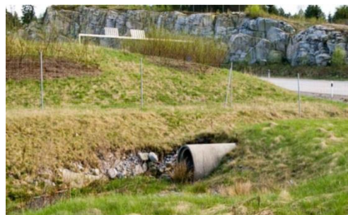
Figur 3-14: När trumman sticker fram långt ur slänten blir den iögonfallande. (Foto Trv Vägbilder)
