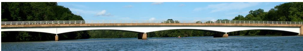
Figur 4-9 Exempel på brotformning med ett splittrat utseende. Brostöd, brobalk, kantbalk och räcke hänger inte samman.
