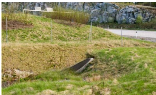
Figur 3-13: En snedskuren trumma smälter bättre in i landskapet. (Foto Trv Vägbilder)
