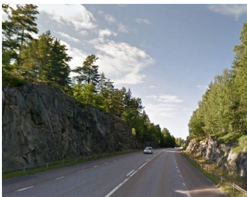
Figur 3-6: Exempel på hög bergskärning längs E22. Bergskärningar är ett vanligt förekommande inslag i vägmiljöerna i Västervik med omnejd.
