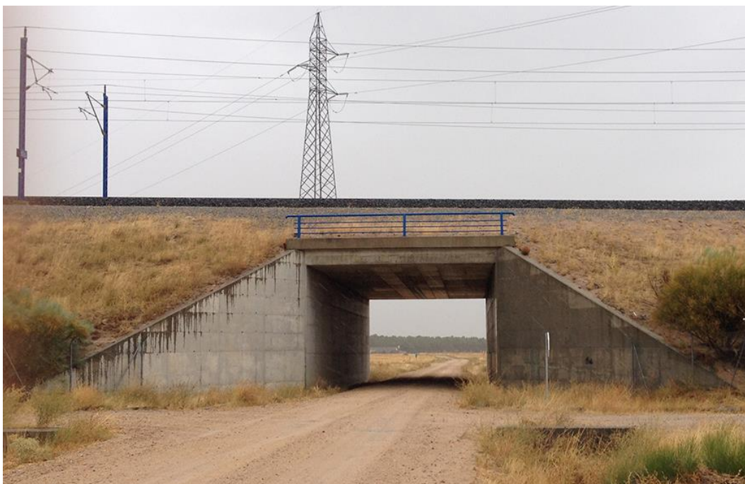
Figur 3-12 Exempel på väl etablerade slänter och god sikt igenom porten.
