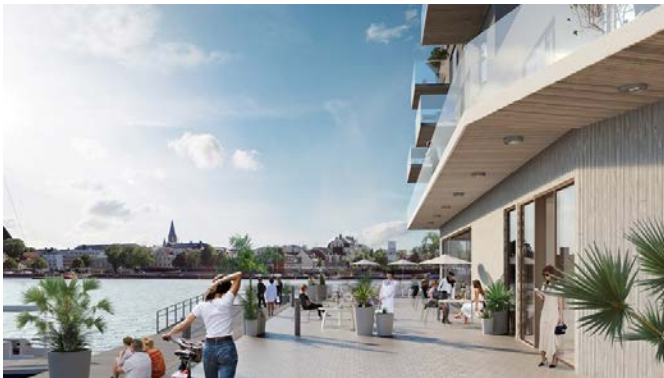
Nybyggnation av bostäder, restaurang, bar, butiker och marina vid Slottsholmen pågår. 38 lägenheter. Klart 2017
