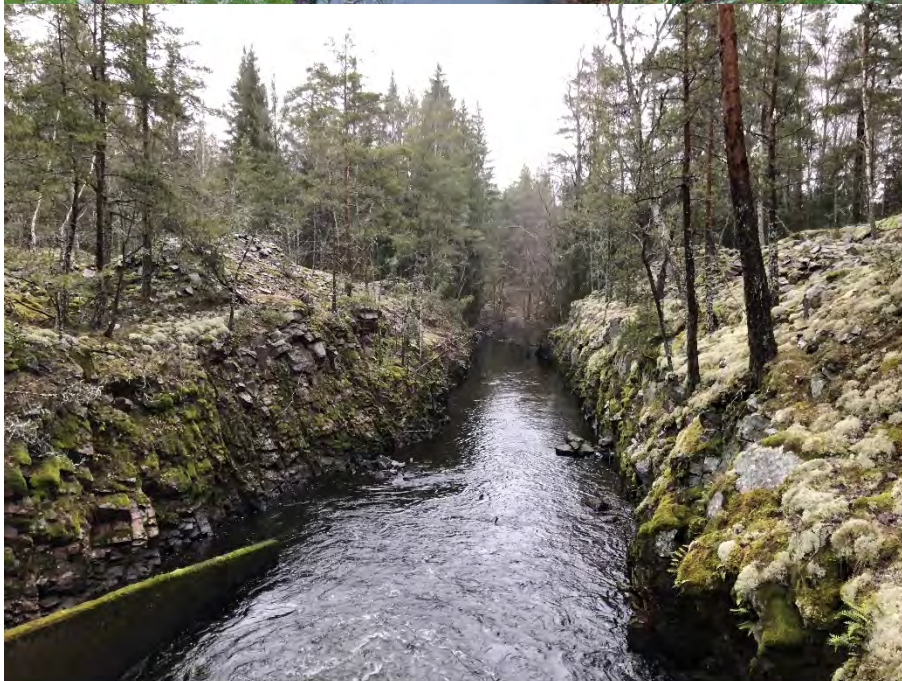
Figur 8. Delsträcka Im 0/020 – 0/060. Berg i dager i åfåra, upplag av sprängsten till höger och vänster om åfåran.
