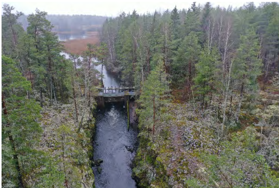
Figur 5. Delsträcka Im 0/000 – 0/040 uppströms riktning. Berg i dager i åfåra, upplag av sprängsten till vänster och till höger om åfåran.
