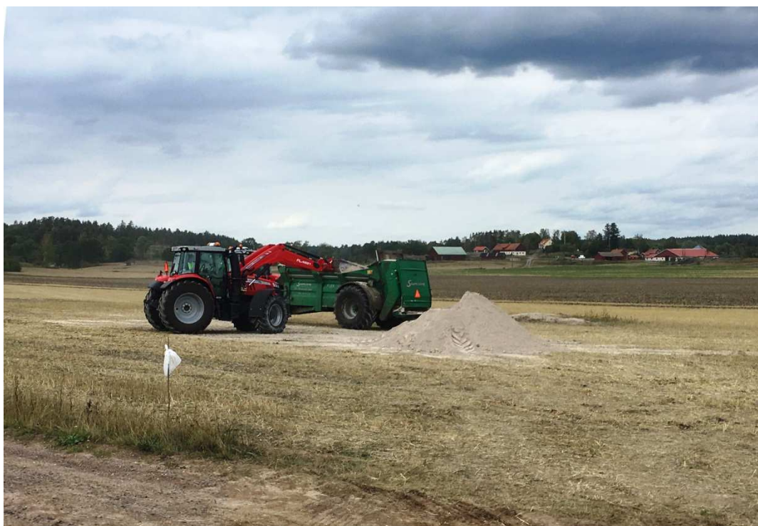
Strukturkalkning på Loftaslätten, sommaren 2018
