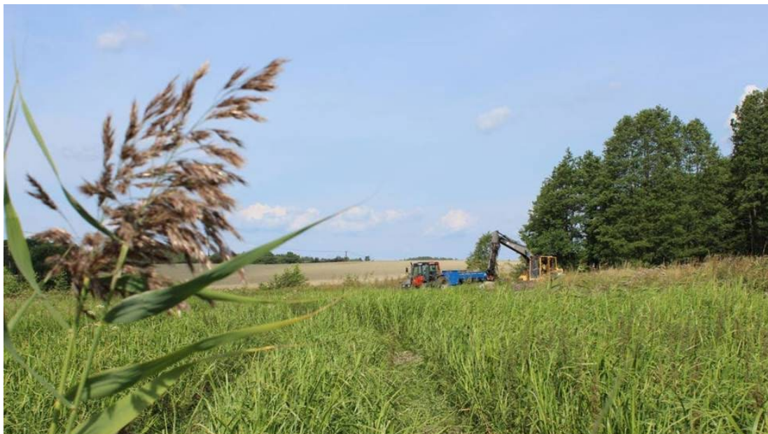
Grävarbete av dammen vid Skramstad
