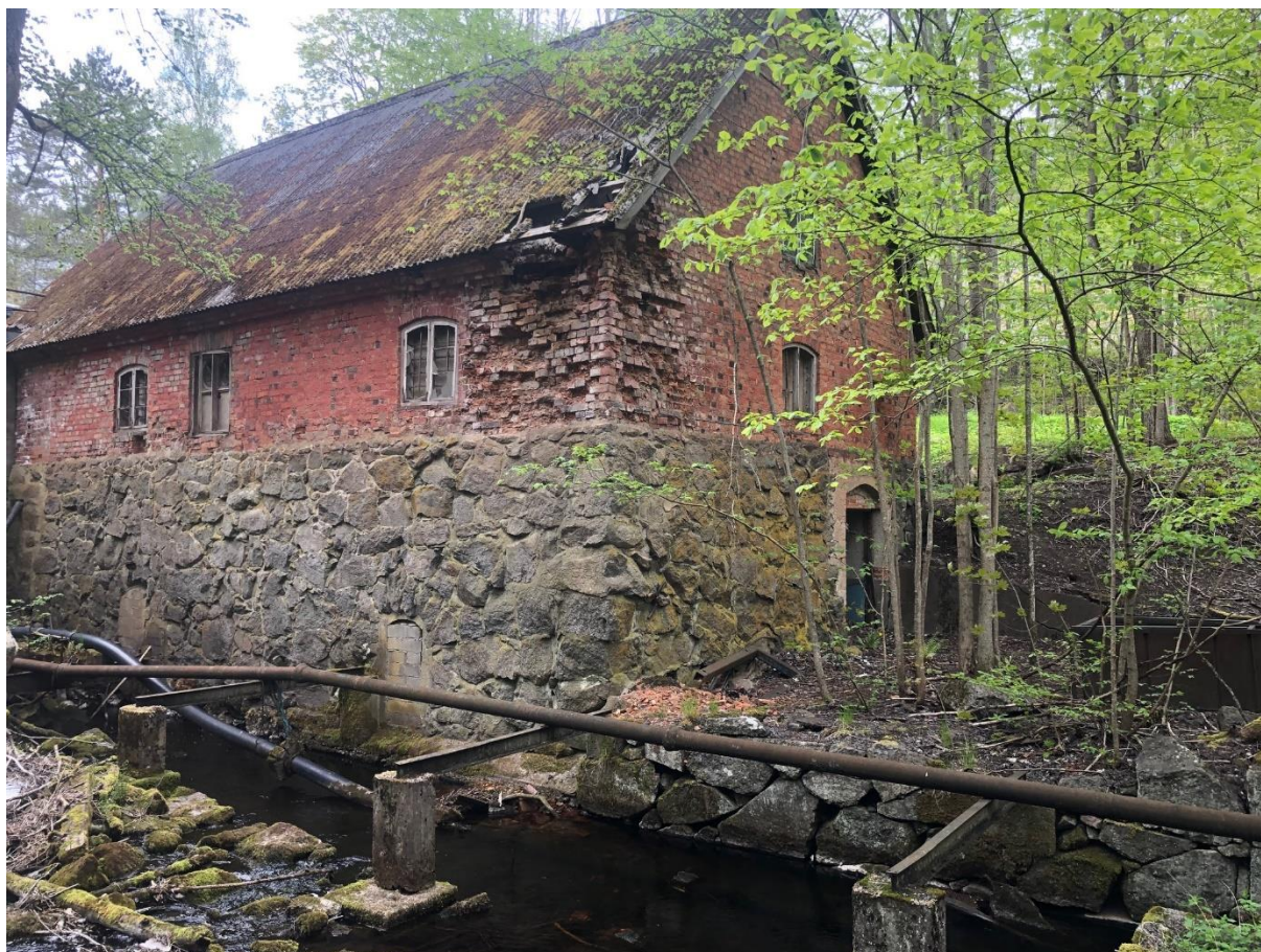
Figur 13. Kraftverksbyggnaden är en viktig symbol för bruksorten Överum. Om möjlighet finns är det värdefullt att den hålls i gott skick.
