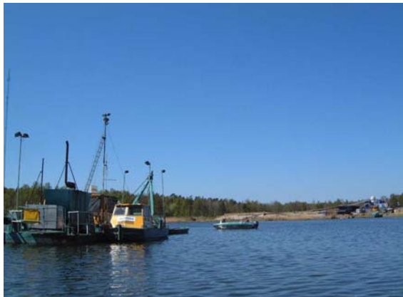
Bild 8.10 : Kontroll av grumling vid undersökningsmuddring.
