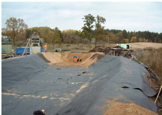
Bild 8.11: Anläggning av filterbassäng.
