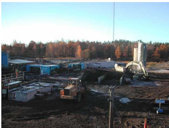
Bild 11.4 och 11.5: Etablering av bassäng för eftersedimentering.
