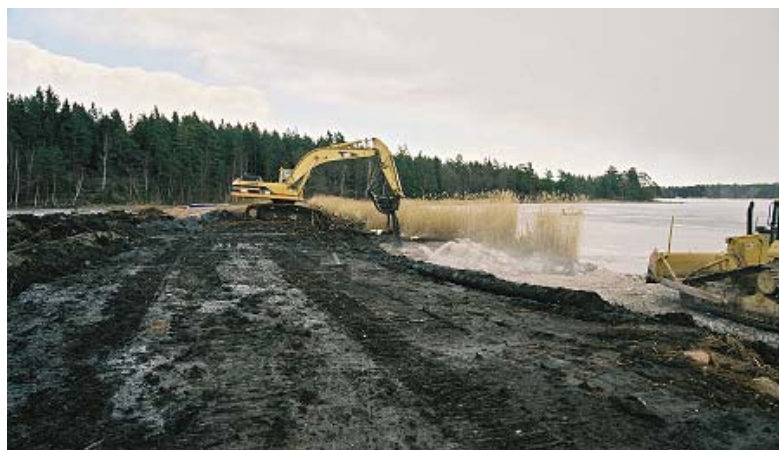
Bild 11.6. Anläggning av stödwall.
