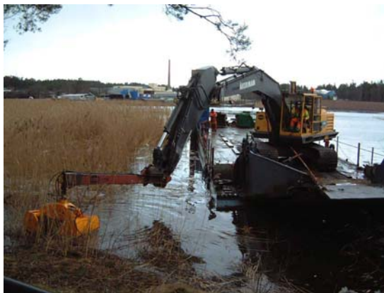
grävmaskin på pråm. För att utföra muddring i vatten krävs tillstånd enligt miljöbalken.
