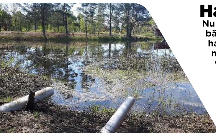
Befintlig damm vid Örbäcken
