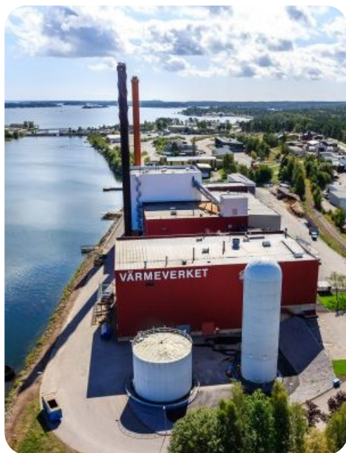
Västerviks Värmeverk - Stegeholm
