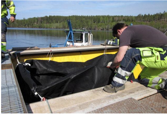
Figur 9.9. Iläggning av säck i bottentömmaren innan uttransport. Foto: Ulrika Palmér Nilsson, EMPIRIKON Konsult AB
