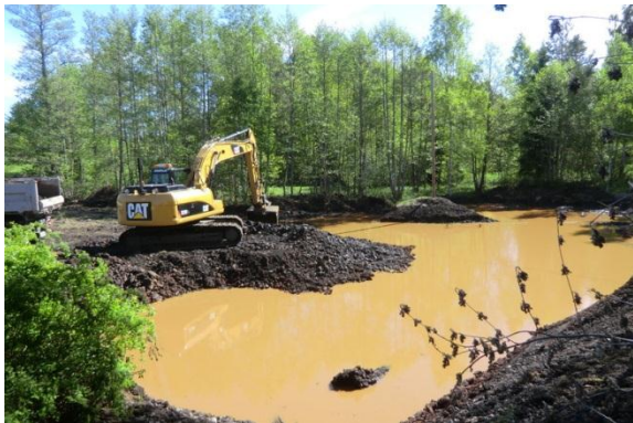
Figur 9.7. Vid Hyttan schaktades även varp under grundvatten ytan, detta utan att grumling kunde konstateras i Torsfallsån. Foto: Ulrika Palmér Nilsson, EMPIRIKON Konsult AB
