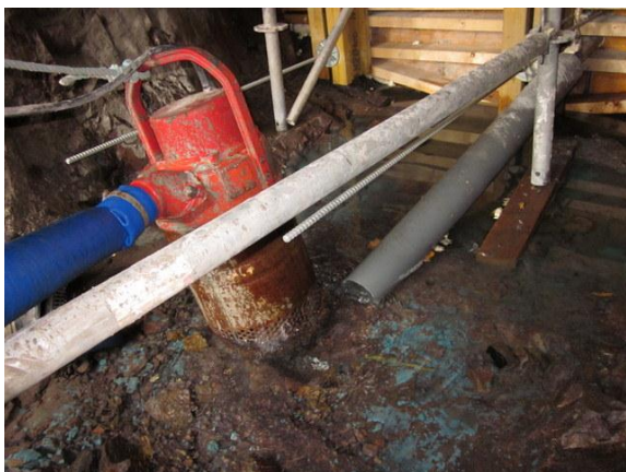
Figur 9.13. Pluggen innan formen togs bort. Det grå röret är genomföringen för dränering av gruvvatten. Foto: Ulrika Palmér Nilsson, EMPIRIKON Konsult AB
