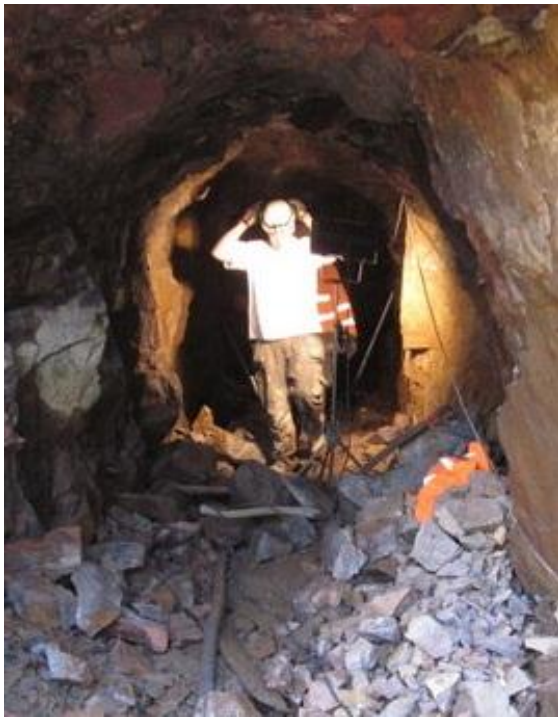
Bild 3.1. Arbeten med skrotning av löst sittande berg pågår i stollgången. Foto: Ulrika Palmér Nilsson, EMPIRIKON Konsult AB
