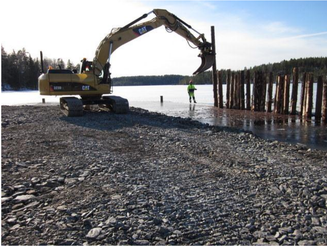
Figur 9.3. Pålning av spont för pir. Foto: Ulrika Palmér Nilsson, EMPIRIKON Konsult AB
