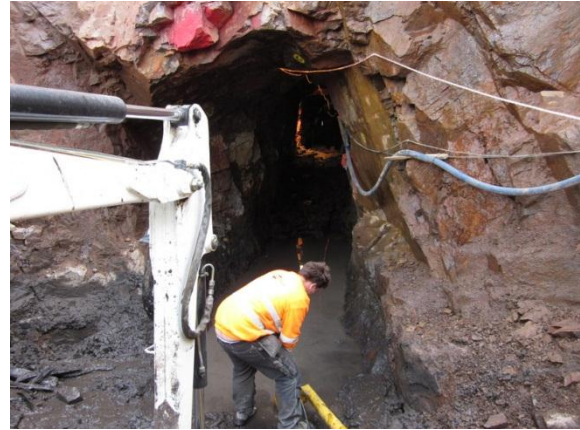
Figur 9.12. Uttransport av skrotat berg från Stollgången i maj 2012. Foto: Ulrika Palmér Nilsson, EMPIRIKON Konsult AB
