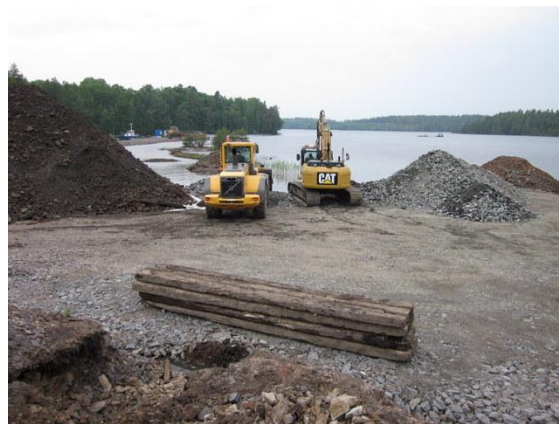
Figur 9.6. Sanering av stranden. I förgrunden syns de plankor som användes vid saneringen för att inte sjunka och inte förorena larvfötterna. Foto: Ulrika Palmér Nilsson, EMPIRIKON Konsult AB
