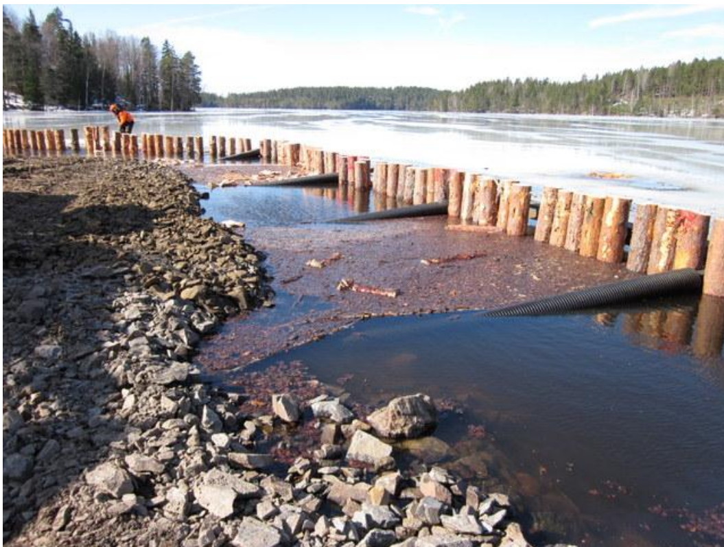
Figur 9.4. Färdig pålspont. Foto: Ulrika Palmér Nilsson, EMPIRIKON Konsult AB
