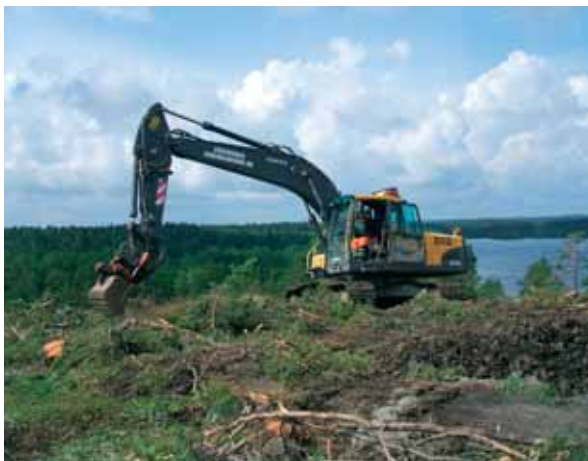
Röjning och schaktning påbörjas på platån Ho23 i Holländarefältets centrala del. Syd om berget ligger Tjursbosjön. Foto: V Palm.
