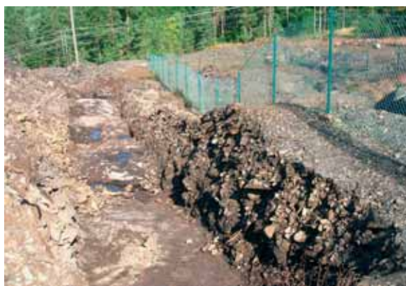
Schakt 3 i översikt från SÖ. Foto: N Nilsson.
