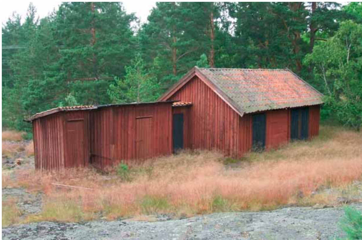
Gruvkontorets uthuslänga Ho72 från SO. Foto: F Sandberg.
