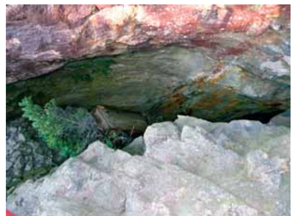
Del av tillmakad gruvvägg i Holländaregruvans mellersta del. Foto:V Palm.
