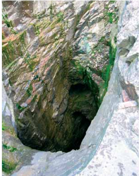
Gamla gruvans schakt Ho43 med spår efter kalkkilning och tillmakning, möjligen även sprängning. Foto: F Sandberg.
