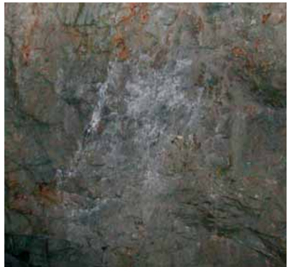
Vita gipsutfällningar i schaktväggen i Bondegruvan: Foto: Västervik kommun.
