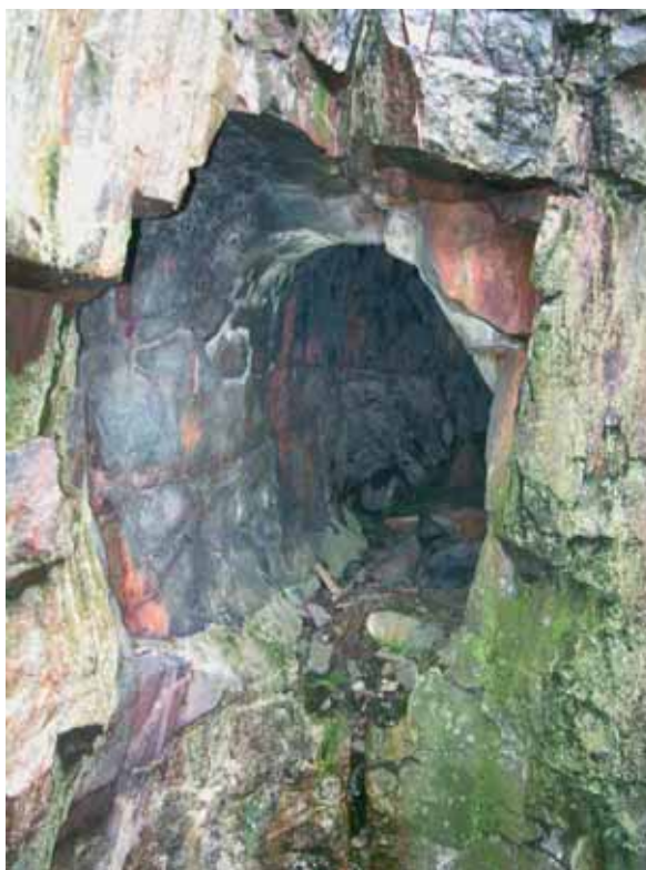
En tillmakad ort mot SÖ i Knuts schakt. Foto:V Palm.
