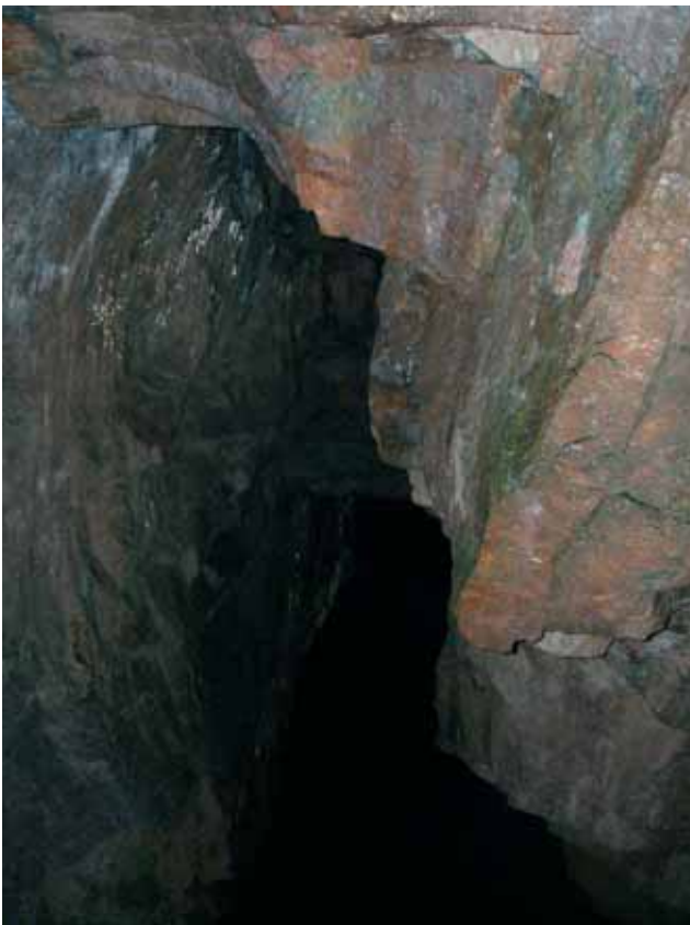
Holländaregruvans schaktväggar är bitvis mycket spruckna och vittrade. Bortom den lilla bergbryggan syns tillmakningsspår. Foto:V Palm.
