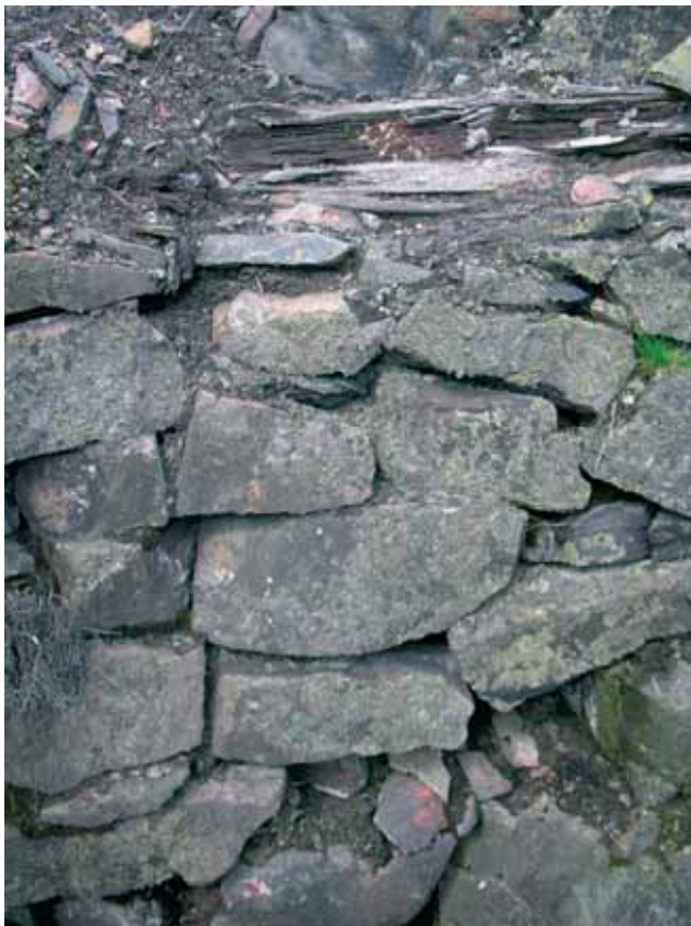
Den östra Tyskgruvan Ho42 med sin kallmurade överdel. Översikt från skylift samt detalj av kallmurens nordvästra del. Foto:V Palm
