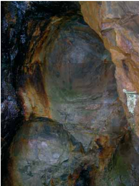
Tillmakningsspår i Östra Tyskgruvan Ho27. Foto:V Palm.
