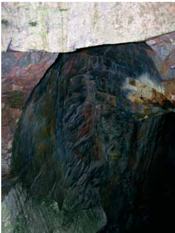
Tillmakningsspår och borrarspår i schaktväggen på Knuts schakt. Foto:V Palm.
