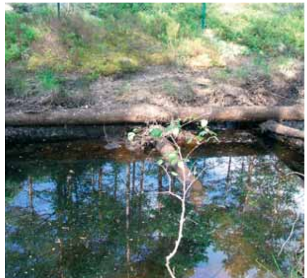
Detalj av timmerkonstruktionen i Hoppet efter vattensänkningen. Foto V Palm.
