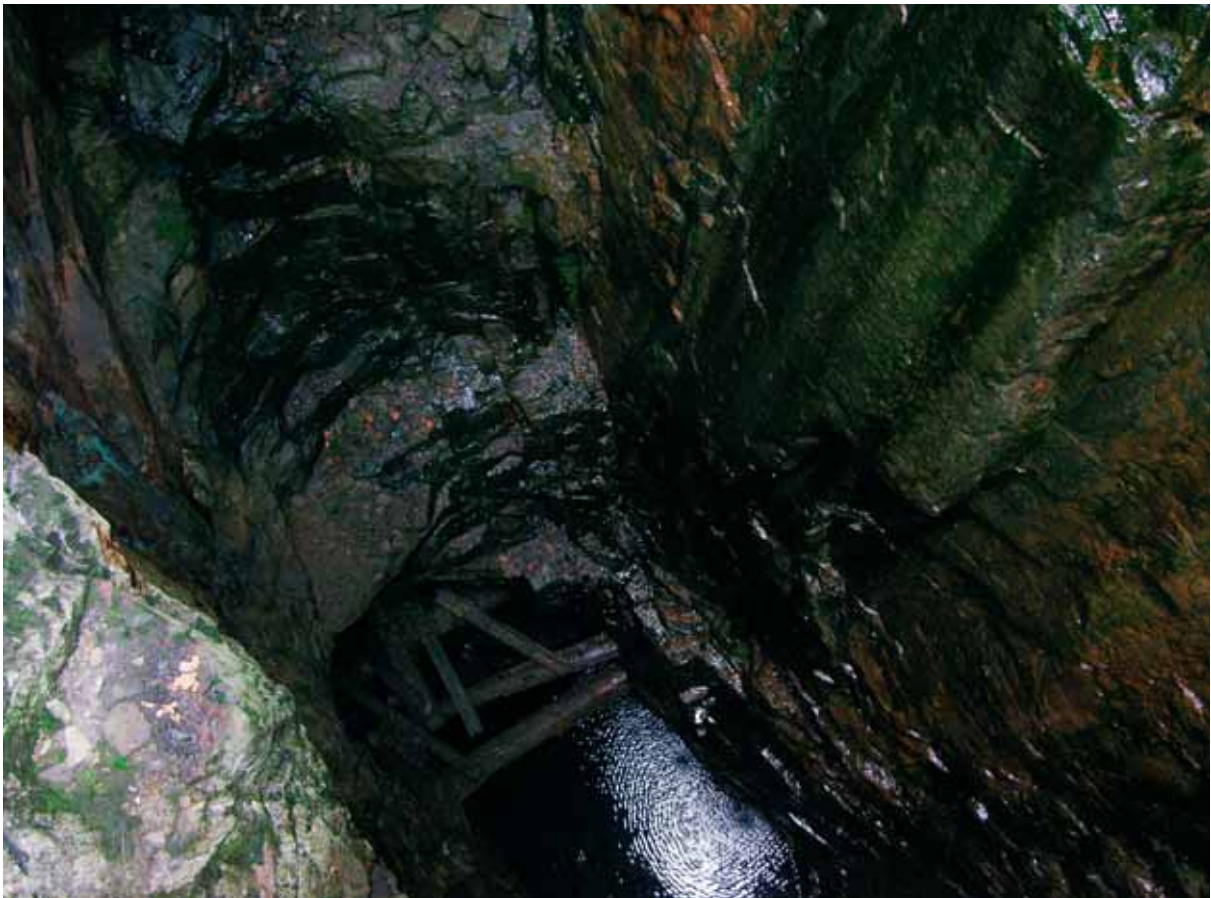
Knuts schakt So100 med bevarade timmerbottnar in mot en ort. Foto: V Palm.
