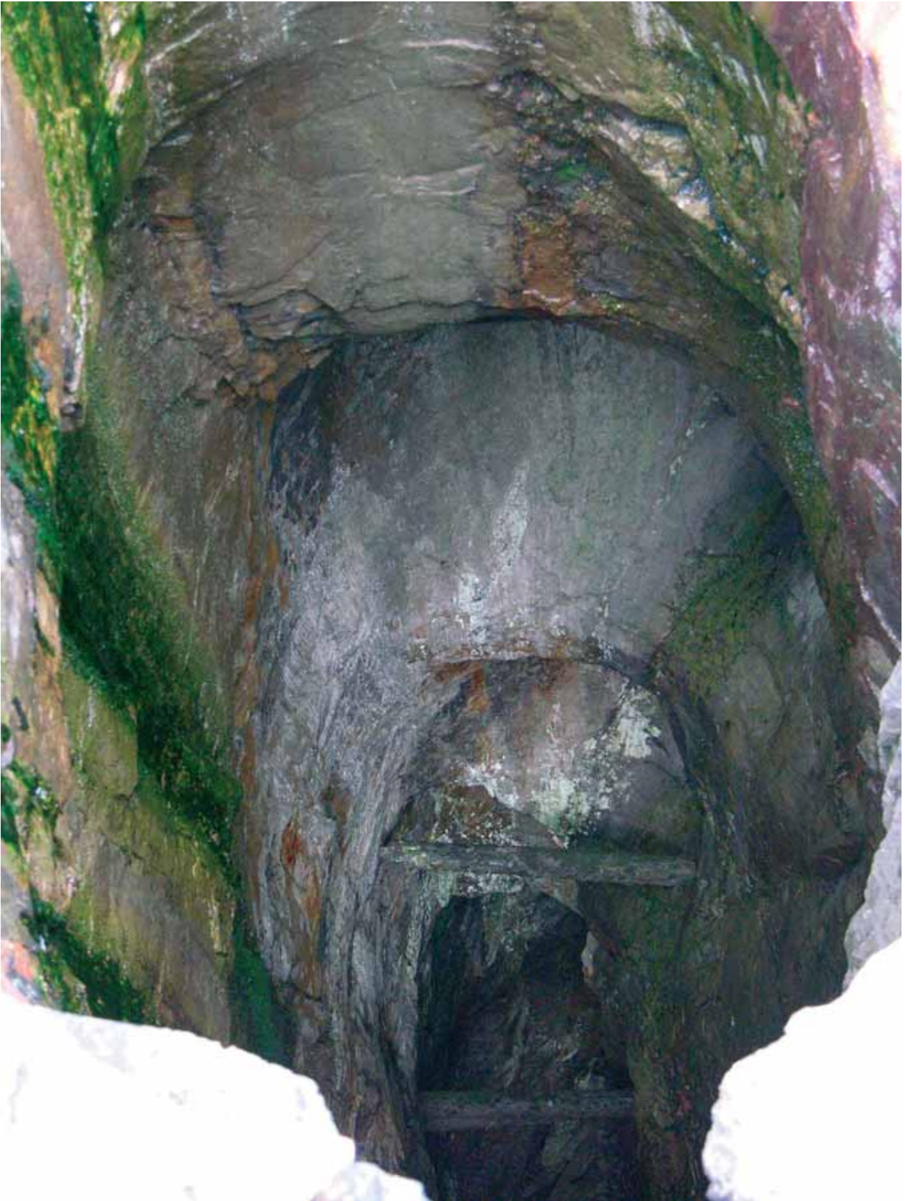
Nya gruvan s schakt Ho57 där man ser tydliga tillmaktningsspår och bevarade timmerstämplingar. Foto: F Sandberg.
