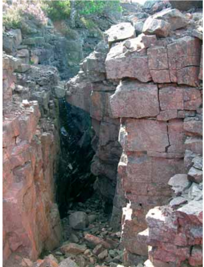
Holländaregruvans schaktväggar är bitvis mycket spruckna och vittrade. Bortom den lilla bergbryggan syns tillmakningsspår. Foto:V Palm.
