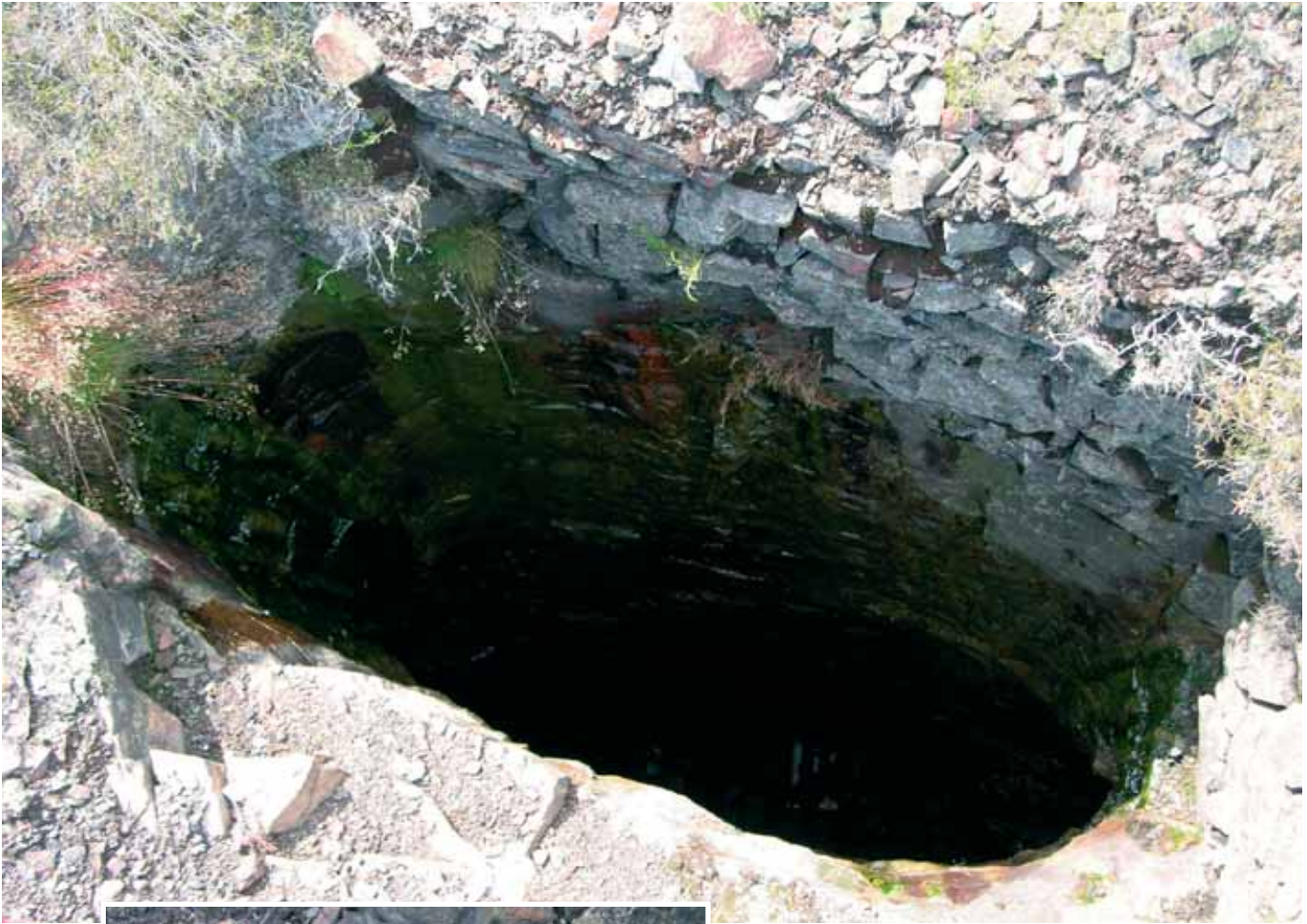
Den östra Tyskgruvan Ho42 med sin kallmurade överdel. Översikt från skylift samt detalj av kallmurens nordvästra del. Foto:V Palm
