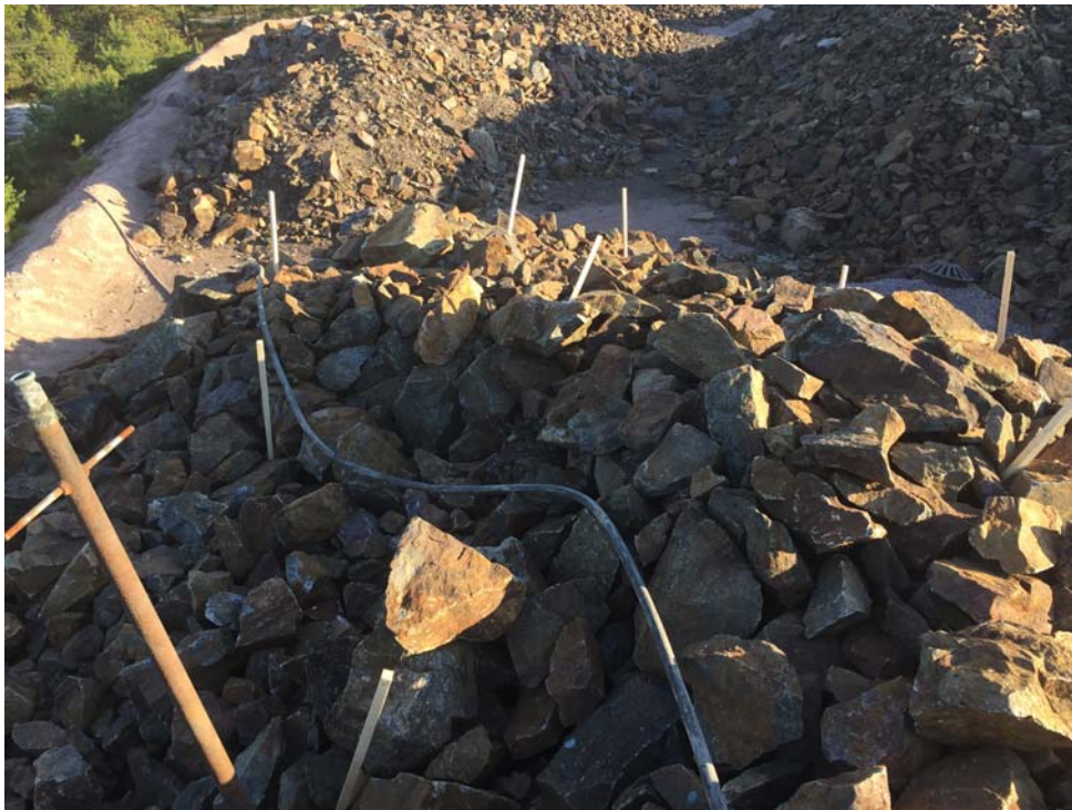
Injektering genomförs i "Eriks hög"
