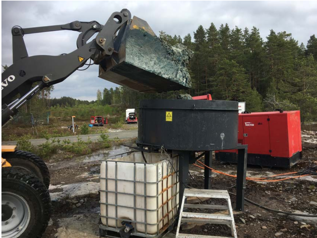
Figur 2: Lastning av grönlutslammet till planblandaren.
