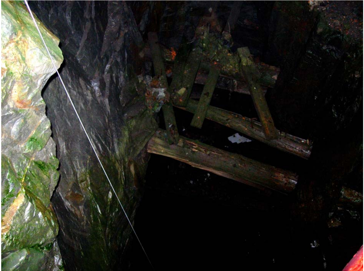
Bild 8. Bild från Knutsschaktet som visar trägolvet vid orten mot Gamla gruvan.
