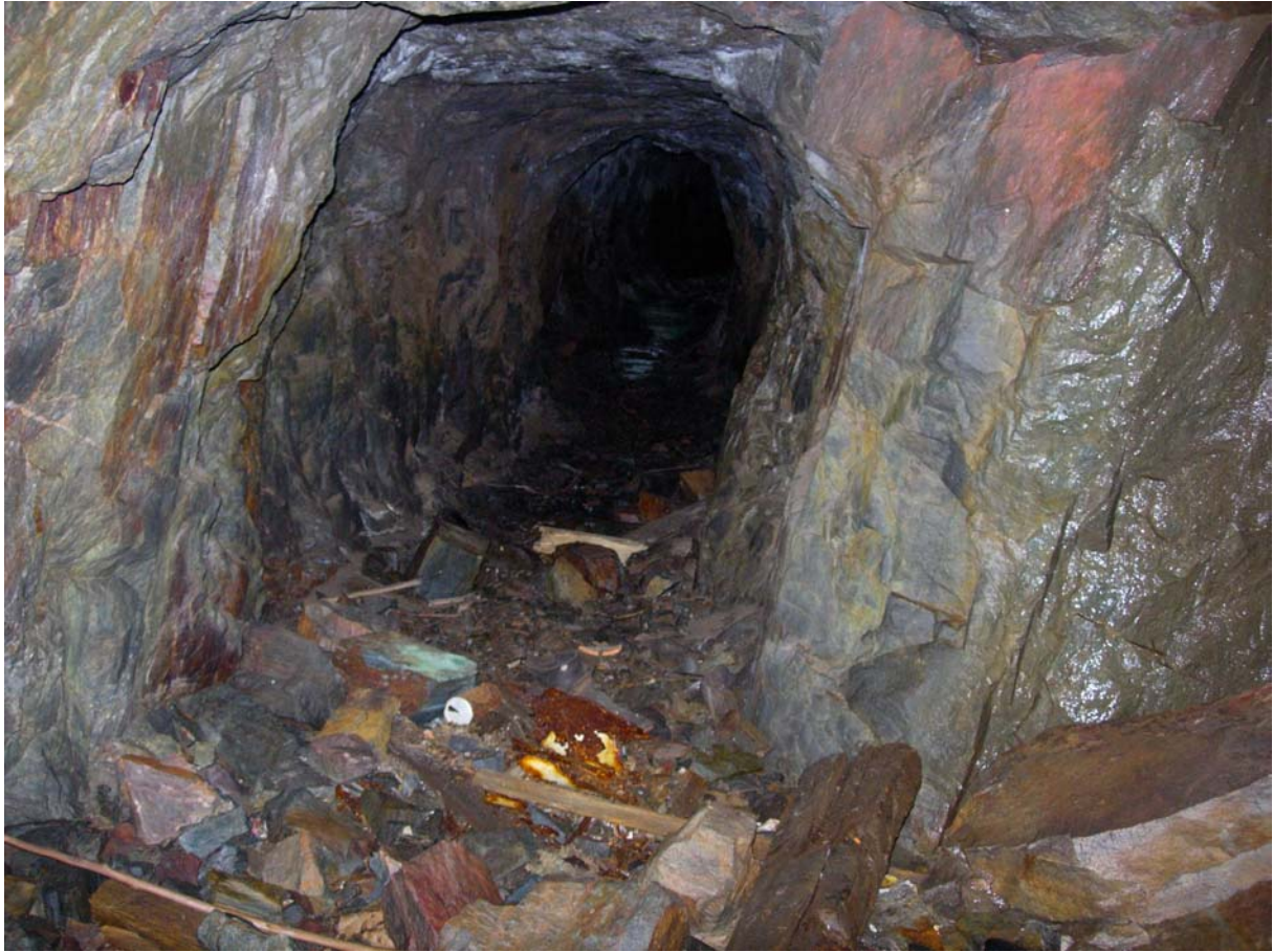
Bild 10. Bild från botten av Knuts schakt som visar en ort med riktning nordost mot masterna. Observera de vita utfällningarna i ortens tak.
