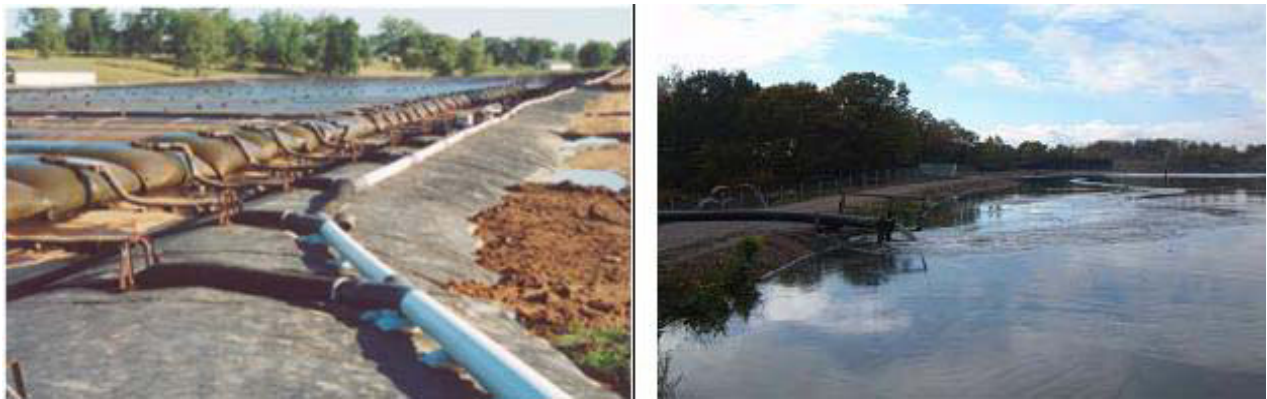
Figur 12 Avvattning med geotuber (till vänster), passiv avvattning i bassäng (till höger)
