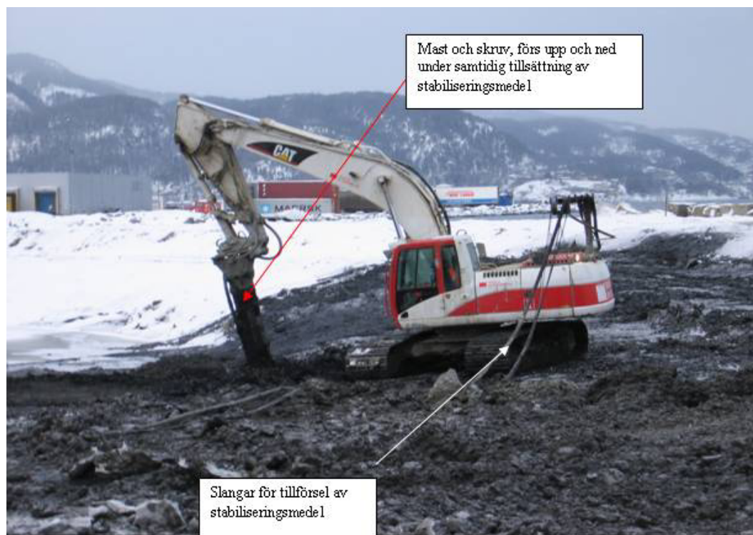
Figur 13 Stabilisering av muddrade sediment med skruv och tillförsel av cementbaserat stabiliseringsmedel (Trondheim, 2003)
