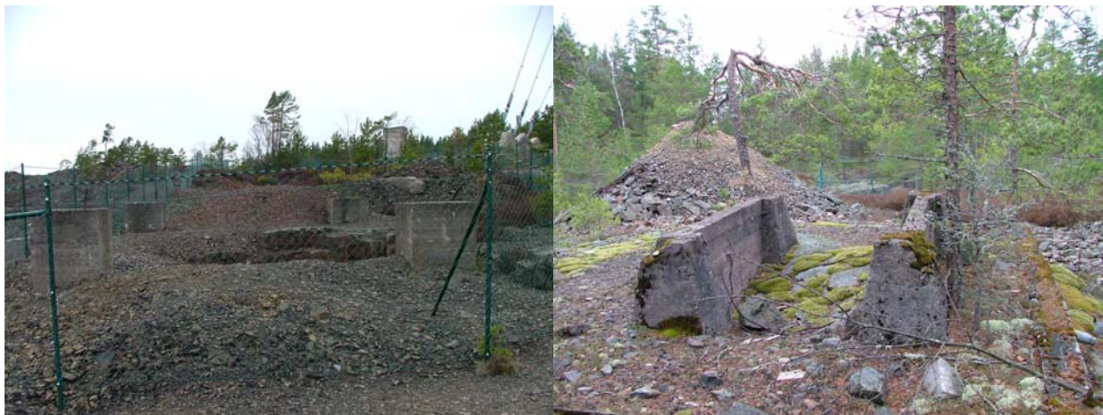
Fig. 17. Bondegruvan (vänstra bilden) och Prins Carls gruva (högra bilden) med sentida inslag i form av betongfundament för uppfodringsanläggningar från 1900-talets gruvdrift. Foto: Håkan Nilsson, Kalmar läns museum.
