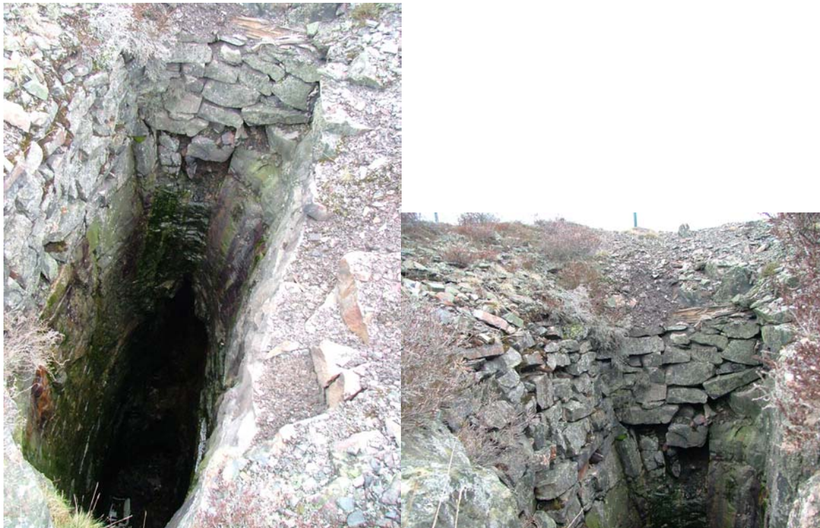
Fig. 11. Tyskgruvan. Kring kanten på det tillmakade gruvhålet är en kallmur med bevarad stensyll. Denna har utgjort fundament till en manuell uppföringsanläggning. På bilden till höger ses att en kraftig lagertillväxt av gråberg i olika fraktioner har skett. Foto: Håkan Nilsson, Kalmar läns museum.
