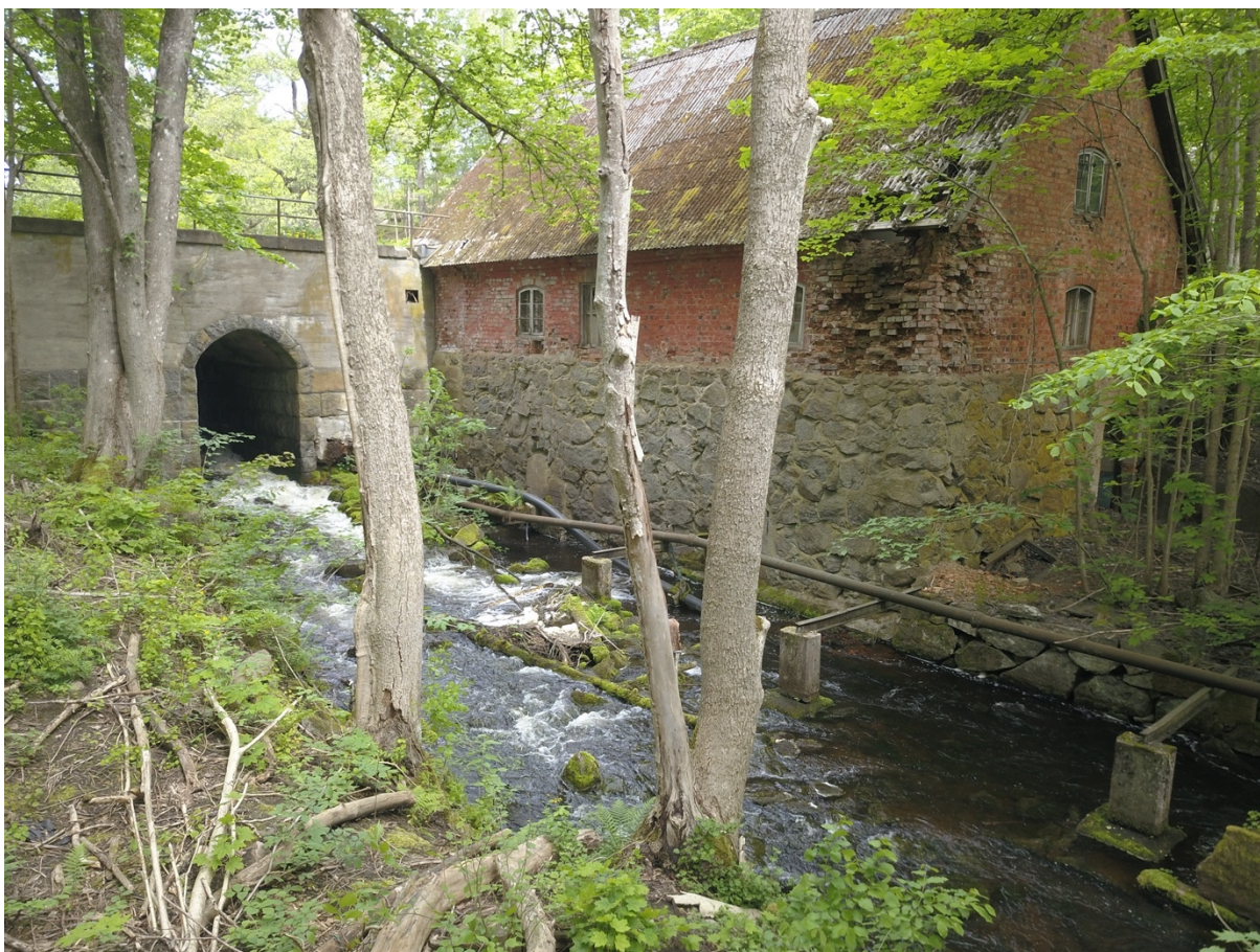
Figur 2. Kvarndammen och kvarnbyggnaden. Dammen har idag endast ett utskov i brukbart skick. Konditionen är otillfredsställande.
