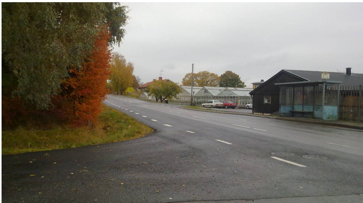
Bild 1. Skymd sikt söderut i korsningen Norrlandsvägen – Ada Rydströms väg.
