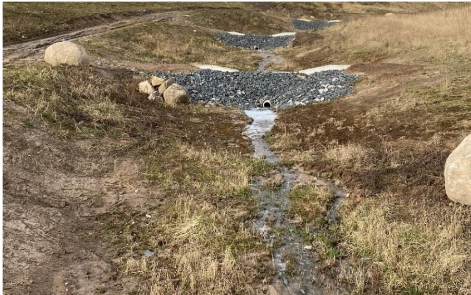
Figur 5. Dike med trappat överfall (Dahlin, 2020)
