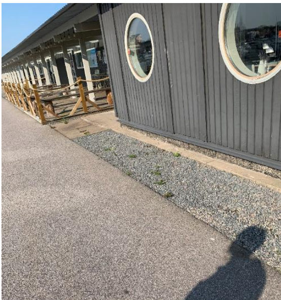
Figur 15. Infiltrationsmöjligheter utmed befintlig fasad, Tändstickan 7
