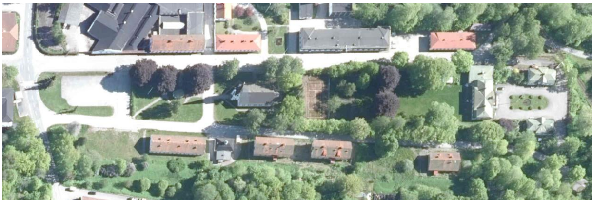
Figur 6. Så här ser bruksmiljön kring Brukstorget ut idag. Husen som beskrivs nedan ligger på Vallongatan som är den nedre av de två parallella gatorna i bild. Från vänster är det Övre Stenhuset, (församlingshemmet), Nedre Knäppet, Övre Knäppet och Staten. Till höger i bild är Överums Herrgård med flygelbyggnader. Ytan mellan herrgården och grustennisplanen mitt i bild, består av herrgårdens trädgård. Byggnaden med svart tak i mitten av bilden är kyrkan. Byggnaderna överst i bild, längs Bruksgatan är byggnader som används aktivt av Överums Bruk AB.
