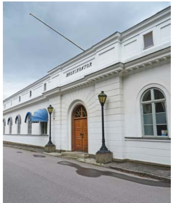
Detalj av den vitputsade fasaden på brukskontoret, ursprungligen stall. "Tjustempiren" utmärks exempelvis av putsfasad, rusticeringar i fasadens nedre parti, släta listverk och flacka tak. De profilerade gesimsen markerar byggnadens horisontalitet.
