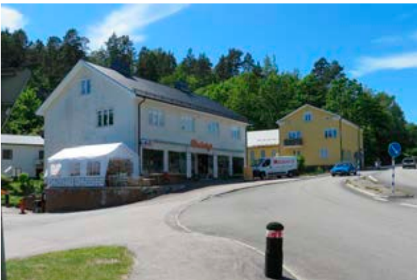
Flerfamiljshus med butiklokal i bottenvåningen utmed Dalhemsvägen. I bakgrunden ses Filadelfiakyrkan.
