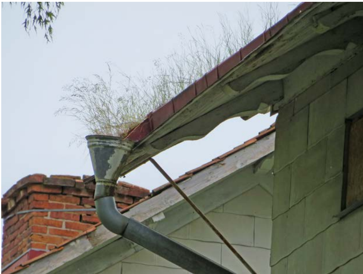
”Nedre Knäppet”. Hängrännor och stuprör är i behov av översyn och rensning.
