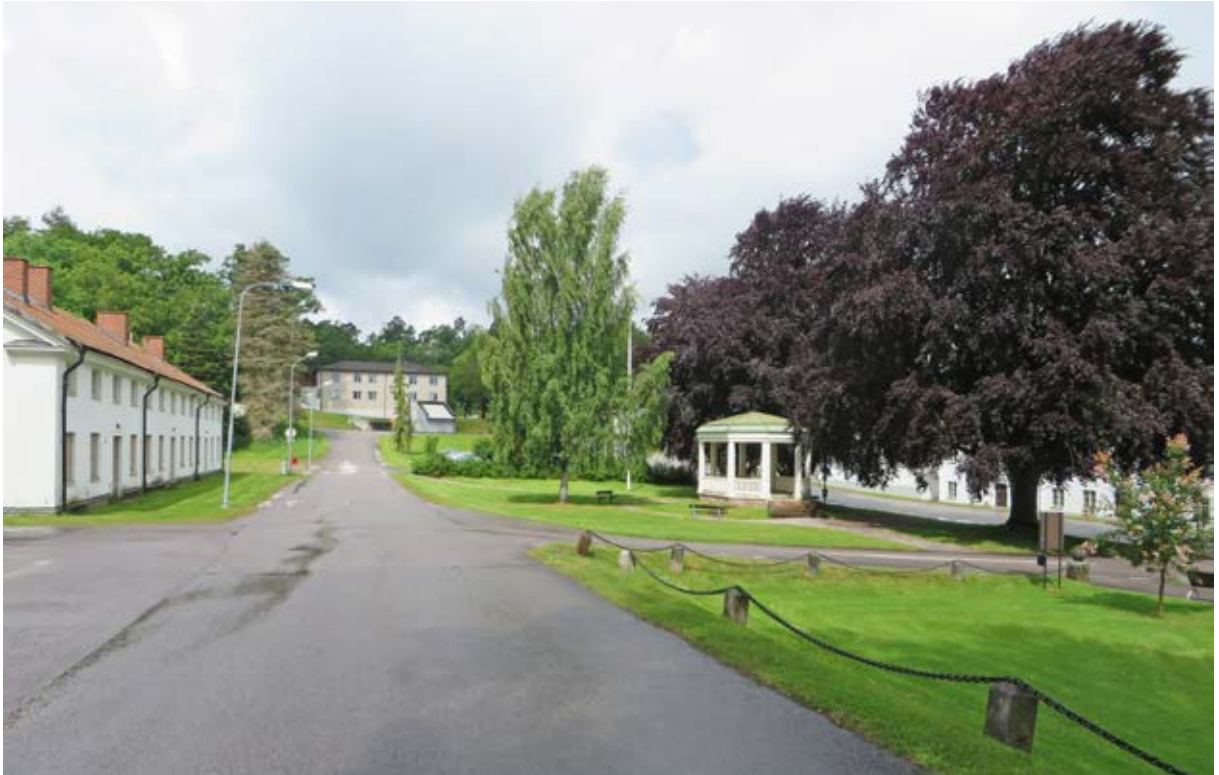
Det "Övre stenhuset" har en tydlig gestaltningsmässigt samhörighet med det "Nedre stenhuset". Båda byggnaderna har viktiga miljöskapande värden för den öppna torgytan.
