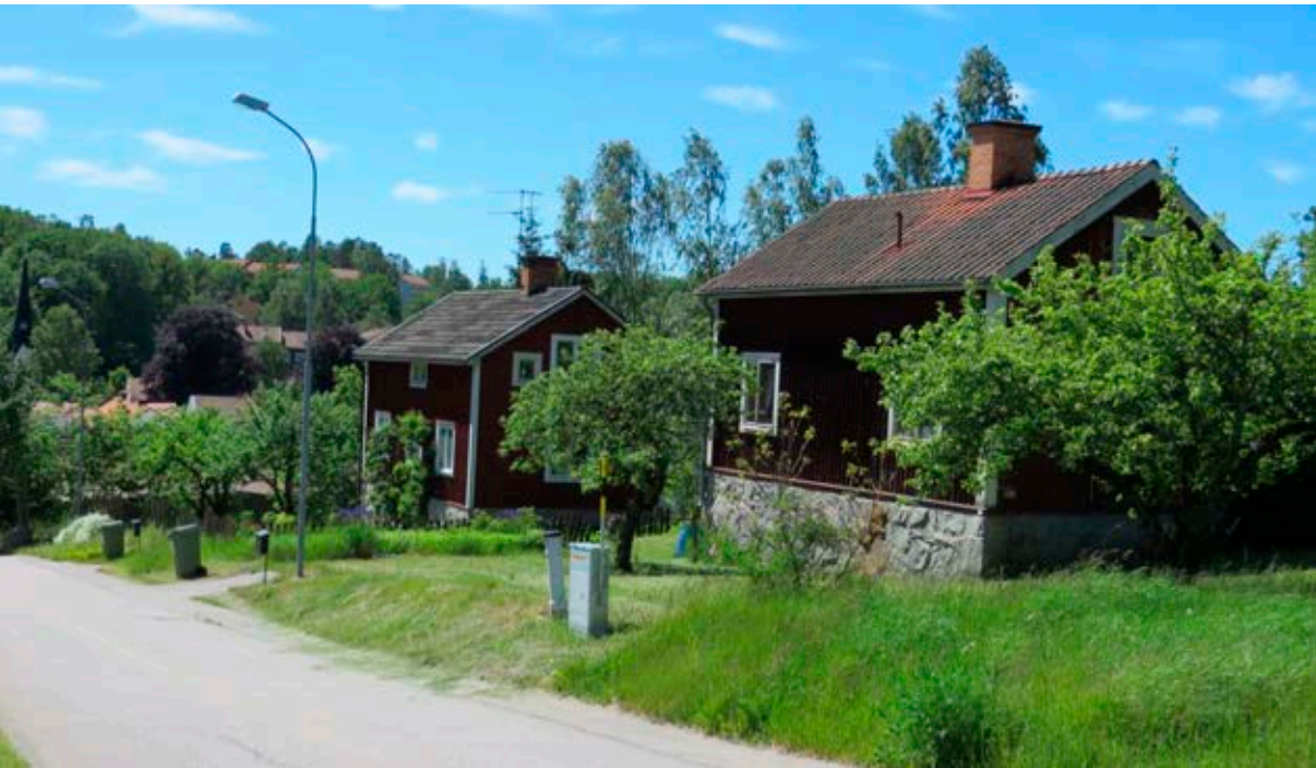
Två av de sammanlagt nio f.d. arbetarbostäderna i Skarpens hage, norr om bruksområdet.
