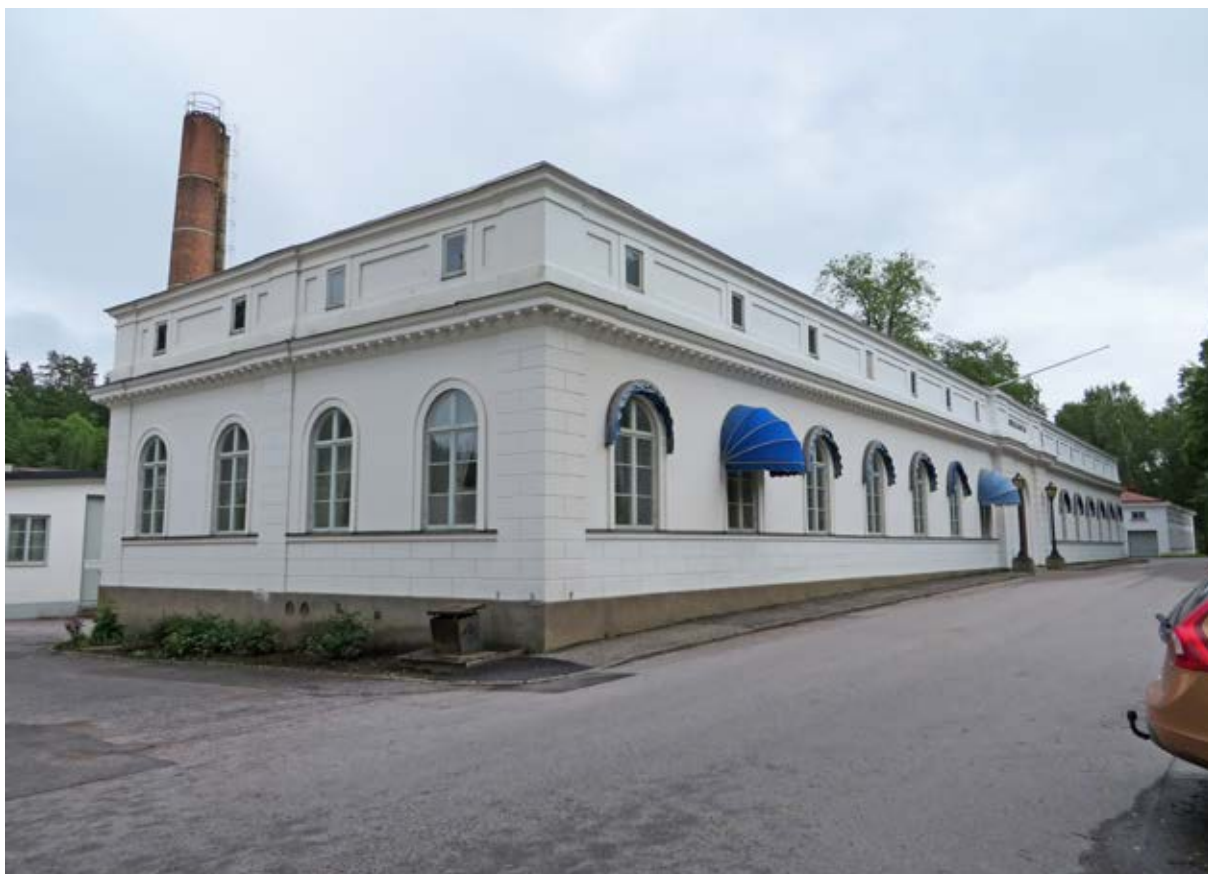
Byggnaden uppfördes 1846 som stall åt herrgårdens hästar, men byggdes senare om till brukskontor.
