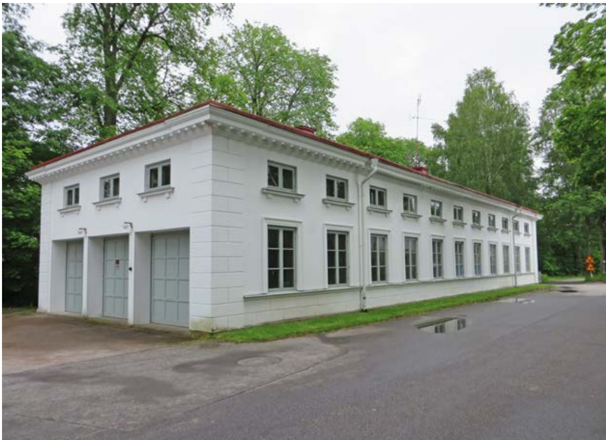
Byggnaden uppfördes på 1840-talet som vagnsbod åt herrgårdens hästskjutsar.
