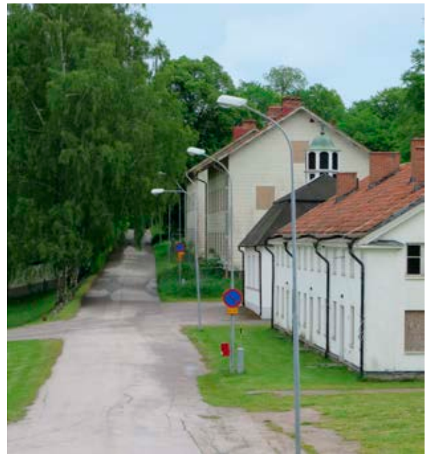
De gamla arbetarbostäderna utmed Vallongatan.
