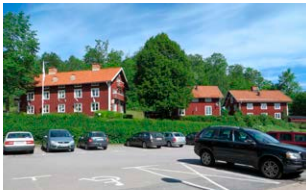
Nordväst om bruksområdet ligger ytterligare tre hus som uppförts som arbetarbostäder, idag vandrarhem.
