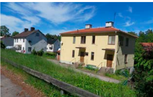
Två mindre flerfamiljshus utmed Övrelundsvägen med välbevarad karaktär.
