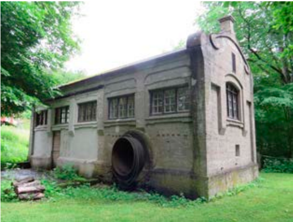
Den nedre kraftstationen.
