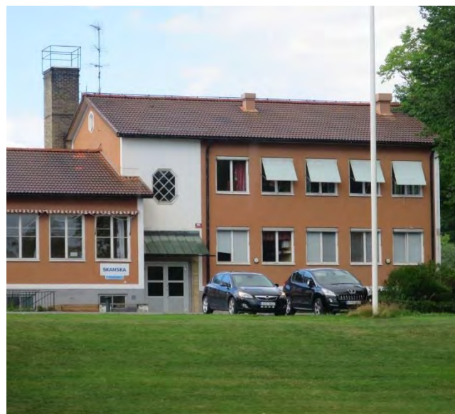
Välbevarad administrationsbyggnad från 1950-talet.
