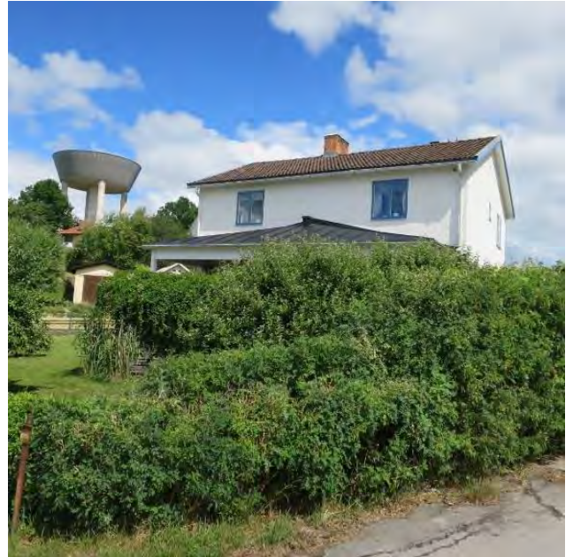
Bakom funkishuset i norra Haga sticker Gamlebys elegant modernistiska vattentorn upp. Vattentornet ritades av Sven Hellgren, Stockholm och stod färdigt 1962.
