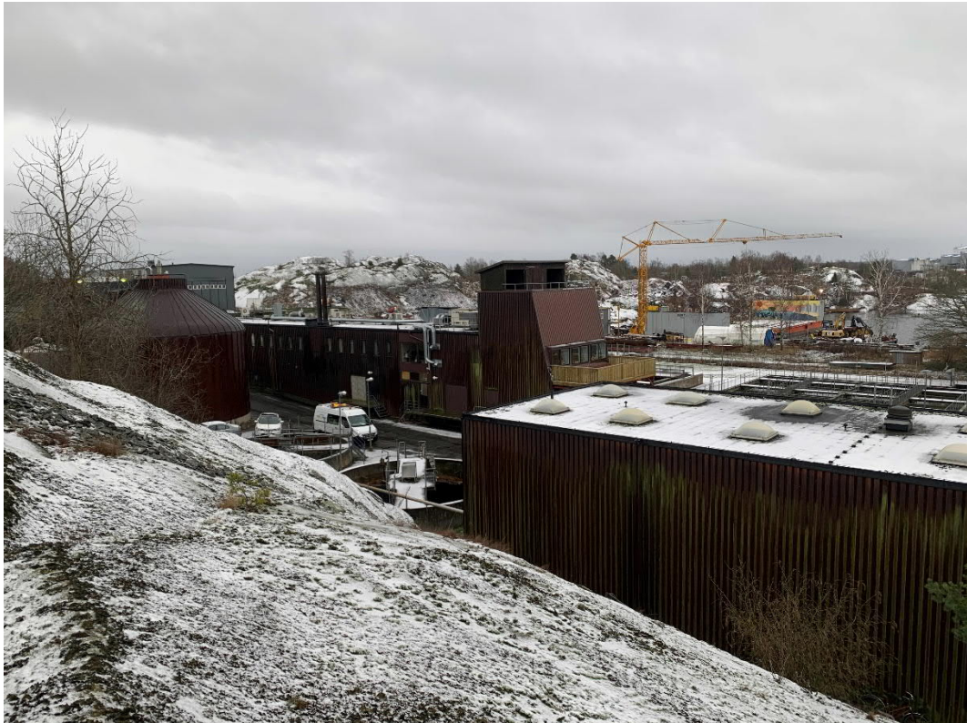
Bild 1: Bild som visar delar av byggnaderna inom befintligt reningsverk. Vy mot sydost.
