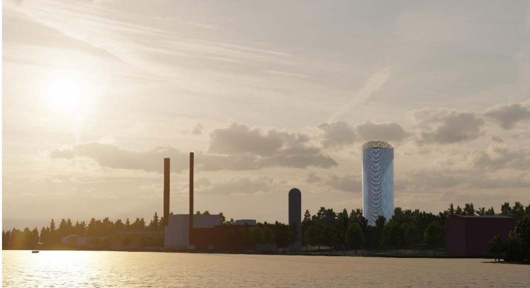
Figur 23. I. Ackumulatorn syns väl från vattnet. Visionsbilden visar utformning och gestaltning av ackumulatortanken. Ett reflekterande material klär ackumulatortanken och speglar färgerna i vegetation, himmel och hav. Kontrasterande ribbor skapar en uppåtsträvande timglasform. Ribbornas form innebär att ackumulatorns uttryck varierar beroende på från vilken riktning ackumulatortanken skådas från (se visionsbildens riktning i figur 22.).
