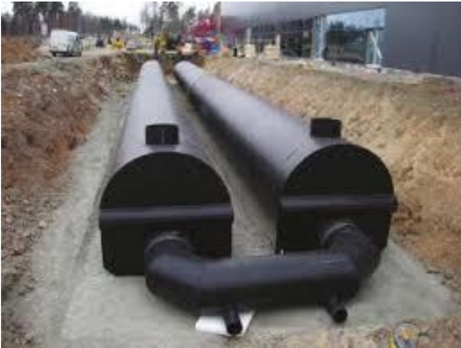
Figur 19. Rörmagasin. (Stockholms vatten och avfall AB 2016)
