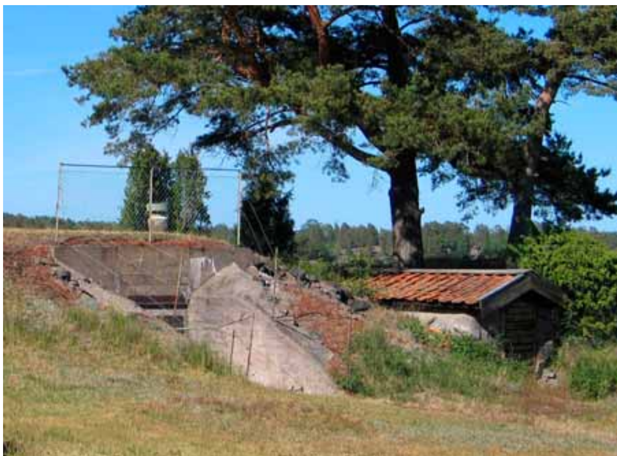
Fig. 19. En bunkeranläggning på Borgös nordöstra udde. Intill ligger en källare tillhörande den gamla lotsbostaden på ön. Foto: L Lamke 2008.
