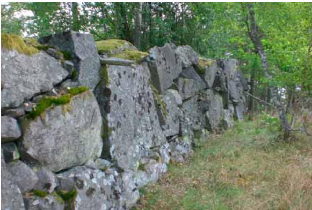
Fig. 28. Befästningsmuren mellan Hästhagsjön och Hornsvägen. I fonden skymtar Hästhagsjön. Foto:V Palm 2008.
