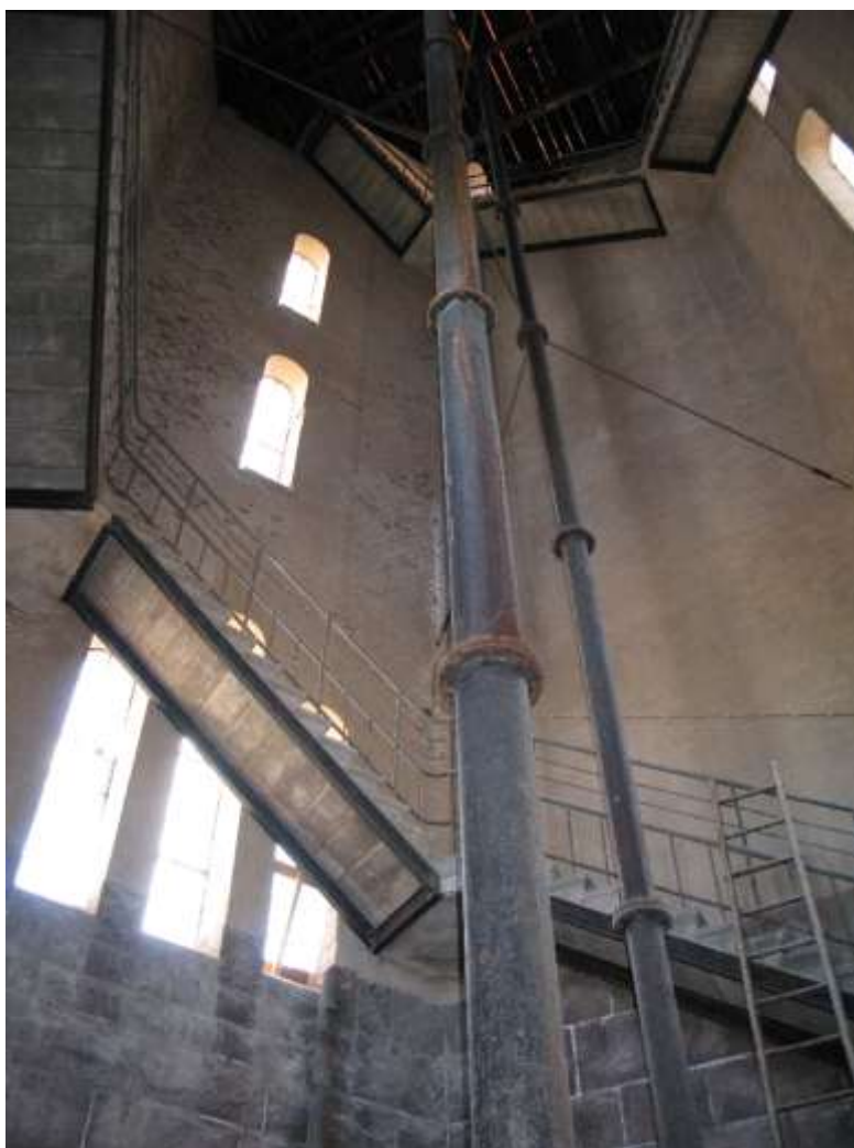
Tornets inre med vattenledningar och trappa.
