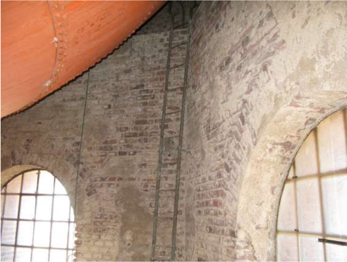
Stegen leder upp till avsatsen där cisternens bärande fundament är fästa.
