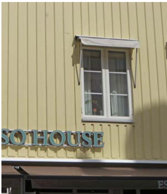
Fasaddetalj av huset på kv. Borgaren 4. Avsaknaden av fönsterfoder är en lokal byggnadstradition som levtt kvar på flera av stadens trähus.
