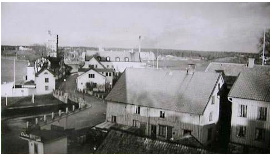
Foto från 1951 över Strömsholmen, som vid denna tid ännu var tätt bebyggd med fabriksbyggnader, bostadshus och varmbadhus. Till höger ses några äldre byggnader i kv. Smugglaren som under 1980-talet ersattes av nya flerfamiljshus. Foto: Tradera.
