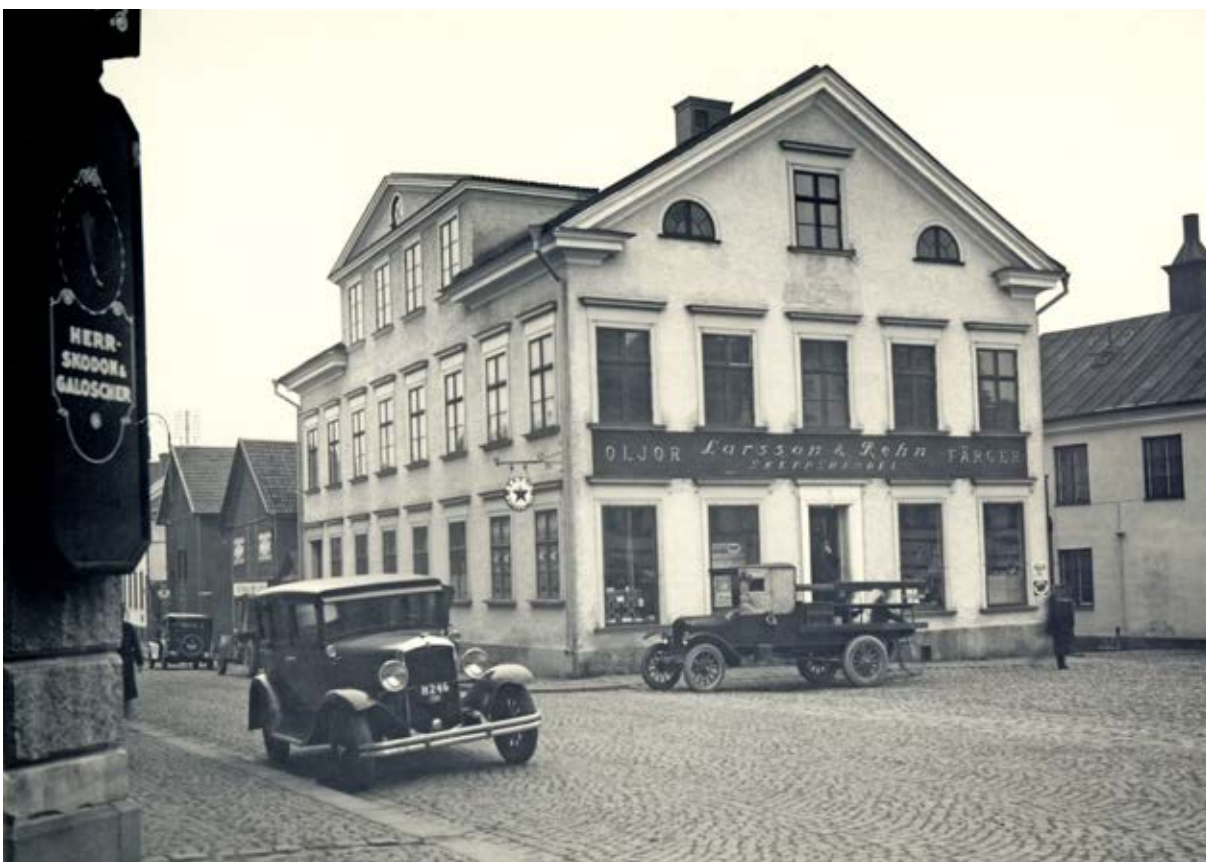
Korsningen Hamngatan – Fiskaretorget under tidigt 1900-tal. Den stora handelsgårdens stora reveterade manbyggnad i kv. Ålen fungerade vid denna tid som järnhandel. År 1928 kom den att byggas om till stadsbibliotek. Foto: KLM bildarkiv.
