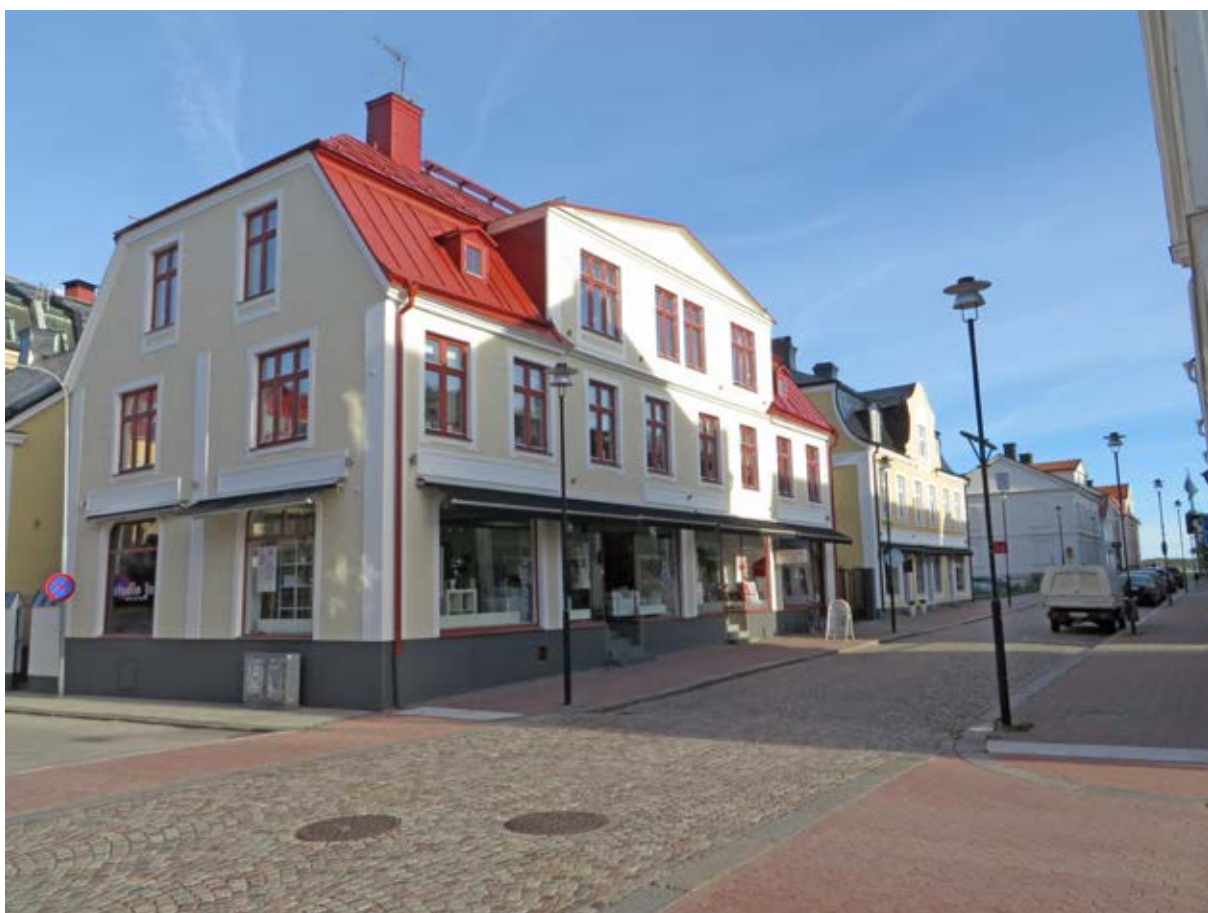
De två husen vid Storgatan i kv. Brukspatronen är exempel på byggnader som uppfördes under 1700-talet, men som under tidigt 1900-tal försågs med frontespiser och putsfasad.
