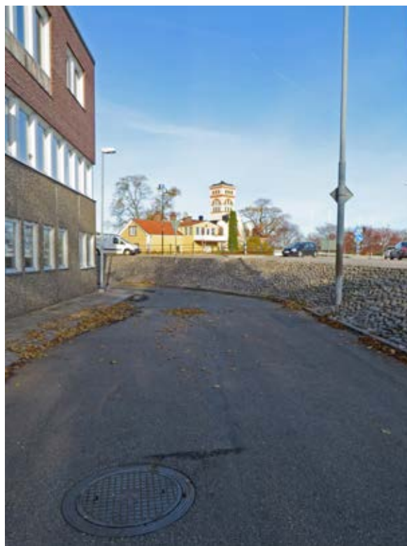
Slottsholmsledens förhöjda vägbank har medfört att Varvsgatan stängts av mot norr.
