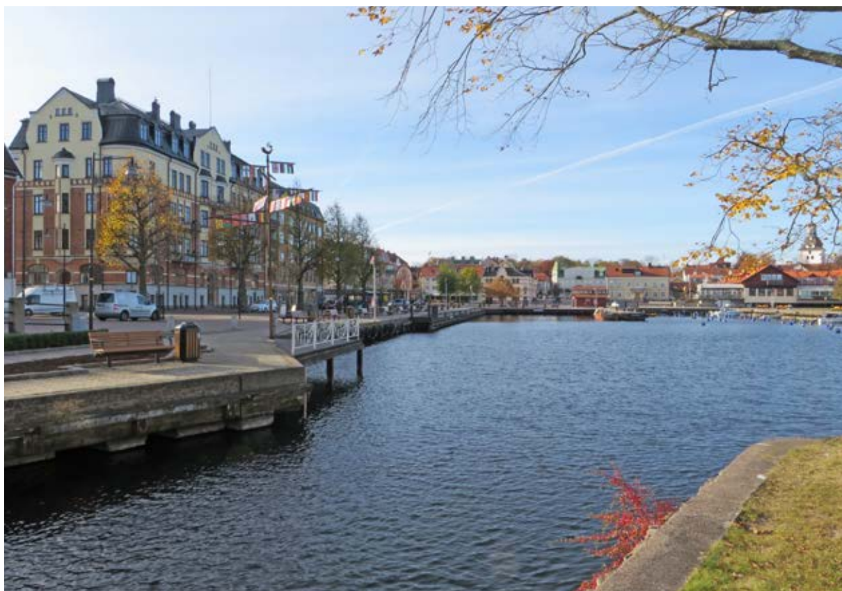
Utblick från Lilla Strömmen mot Fiskaretorget. Strandvägen, kajkanten och Häggbladska huset som kantar gatan berättar om det tidiga 1900-talets stadsomvandling och strävan att ge de mindre städerna ett mer storstadsmässigt utseende. De byggnader som uppfördes under denna tid en iögonfallande utformning enligt tidens rådande stilideal.
