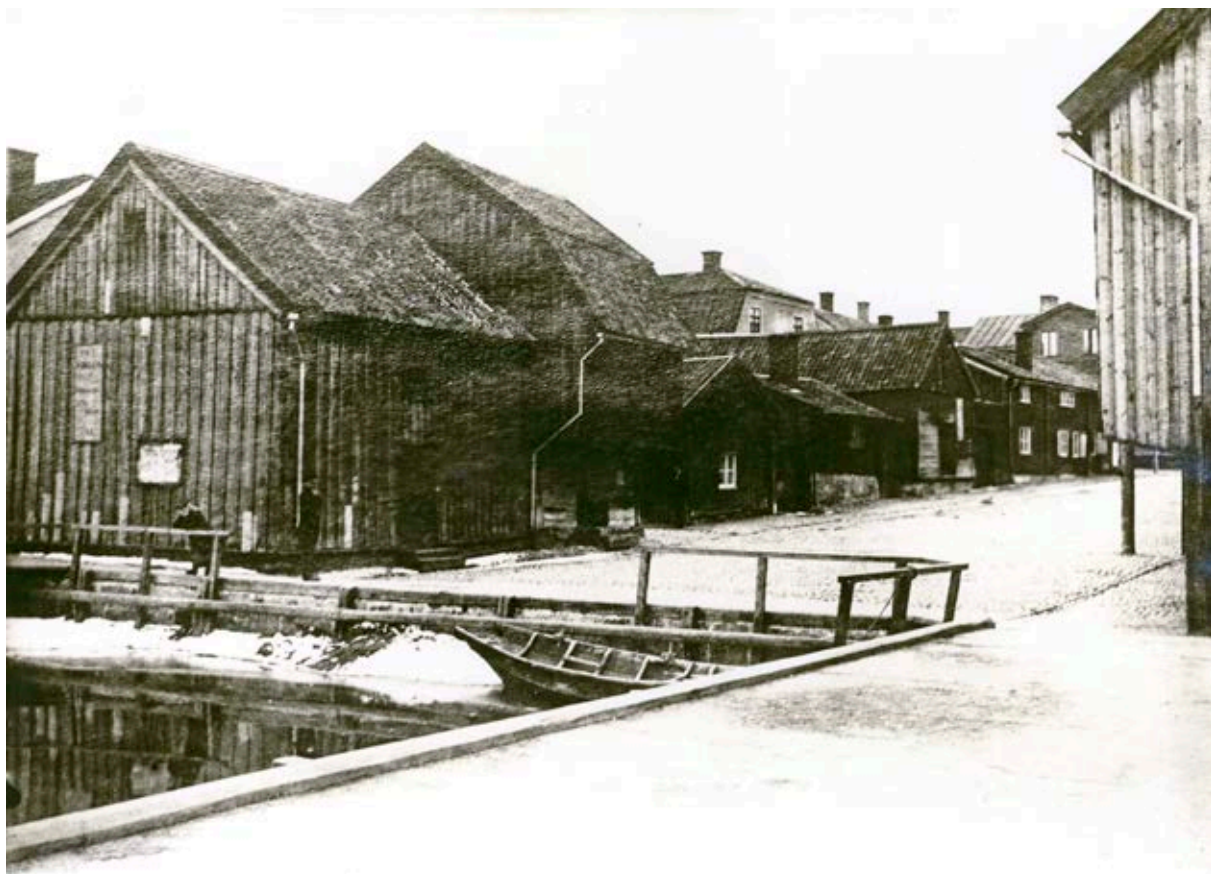
Fiskarhamnen och Fiskaretorget. Torgytan tycks vara belagd med kullersten och kajkanten ser ut att vara stenskodd. HamnpiREN, från vilken fotot är taget, tycks vara av trä. Här ses byggnaderna på torgets södra sida liggandes på rad; magasin, utskottsbodar och bostadshus. Det finns endast en smal passage förbi vid kajkanten. De fyra borte byggnaderna kom år 1911 att ersättas av Saluhallen i kv. Fläsklösa. Foto: KLM bildarkiv.
