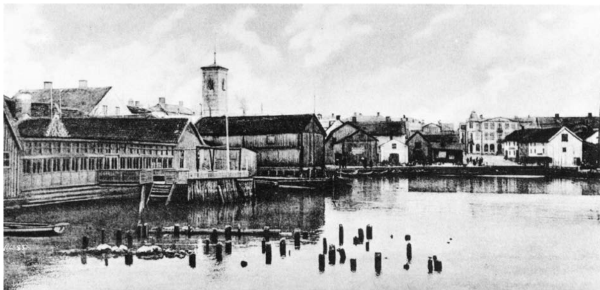
Foto taget strax efter sekelskiftet 1900, troligen taget från bron över Lilla Strömmen. Närmast i bild ses Strandhotellets strandpaviljong. Brandstationens karaktäristiska slangtorn sticker upp bland bebyggelsen. I bildens högra del ses Fiskaretorget. Anderbergskas huset vid Hamngatan uppfördes strax efter sekelskiftet 1900 och ses i fonden av torget. Foto: Scannat ur Kjellgrens bok "Västervik 1900 till 1930".
