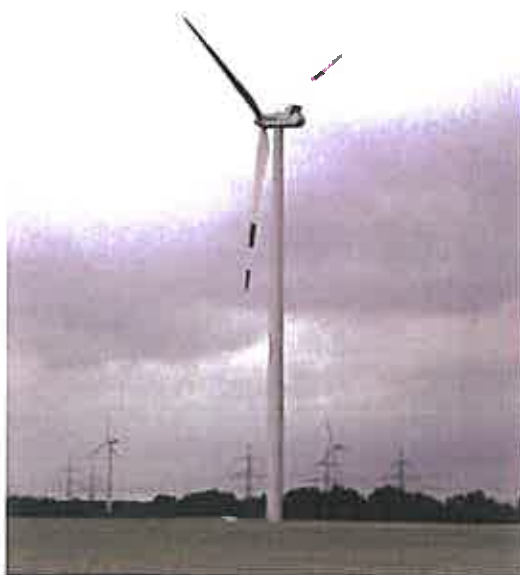
Vindpark vid Cottbus, Tyskland. Foto J-O Helldin.
