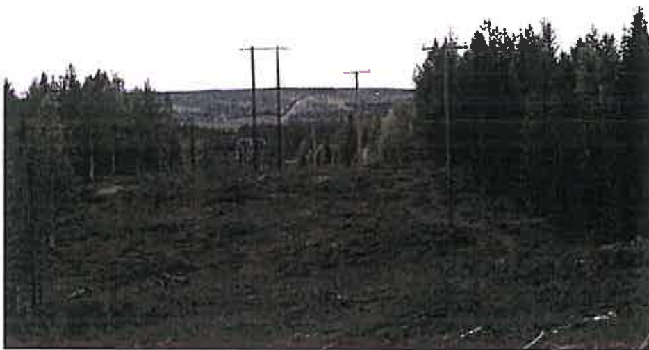
Ny kraftledning i anslutning till Jokkmokklidens vindkraftpark, Malå kommun. I bakgrunden syns även en ny kraftledningsgata till Storlidens vindkraftpark. Foto Anna Skarin.
