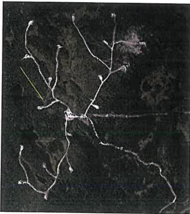
Vindparken i Bliekevare, Västerbotten, där drygt 9 km ny väg byggts, och genomsnittlig vägområdesbredd uppmätts till 21 m (Rönnqvist 2011). Ett skalstreck på 500 m (gul linje) har lagts in. På bilden är vindparken under konstruktion. Från Google Earth.
